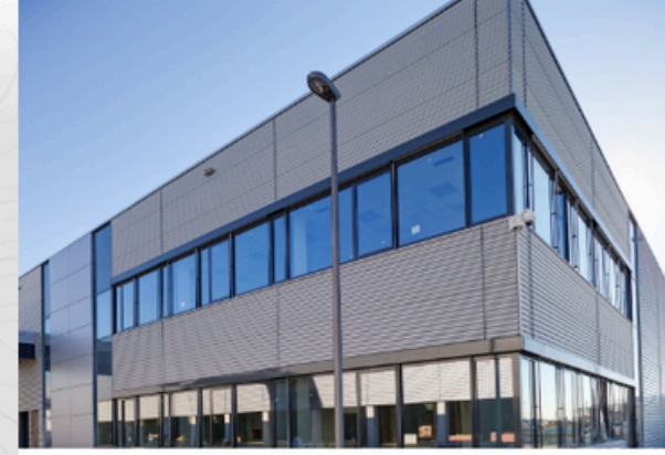
Fabrika Çatı ve Cephe
